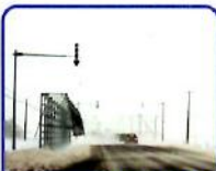
防雪柵(吹き払い柵)
