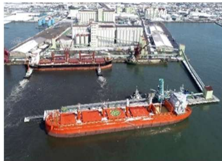
西港区第2埠頭地区国際物流ターミナル
