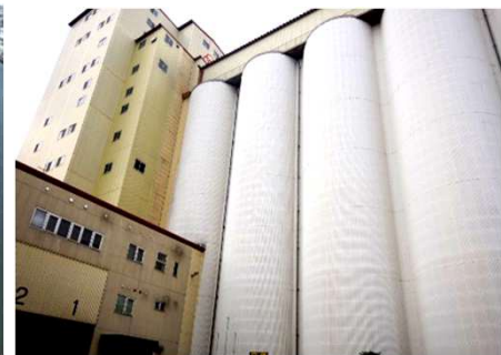
三ツ輪運輸（株）飼料原料貯蔵施設
